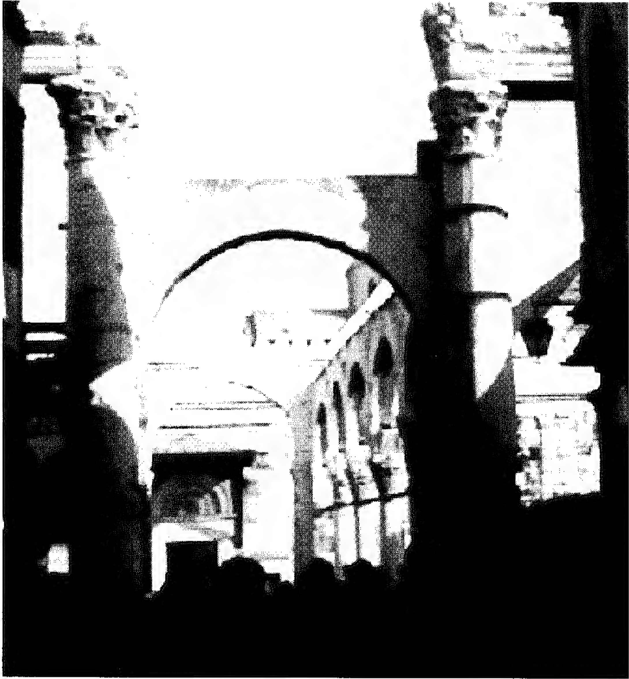
(الشكل ١٨): دمشق، معبد جوبتر، منظر عام للمعبد. يلاحظ ترميم الأعمدة بأطواق صنعت من الفولاذ الدمشقي ومن الحديد.
